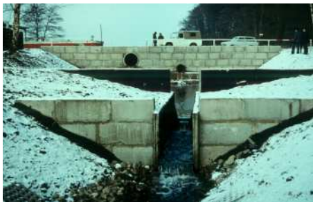
1981 Neues Tosbecken der Krüseliner Mühle
